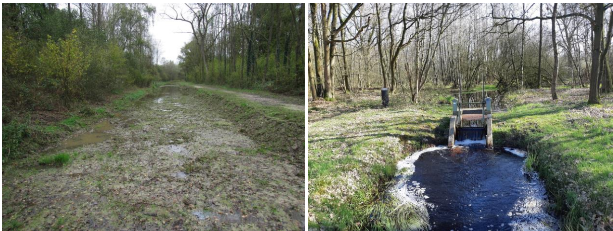
Figuur 3 Hydrologische herstelmaatregelen in Noord-Brabant. Links: Demping van de Zandleij in De Brand bij Udenhout, waardoor minder grondwater onttrokken wordt uit het broekbos (foto: 28 oktober 2017). Rechts: Kunstmatige doorstroming van broekbos in de Strijperheg door opstuwing van het peil middels een stuw (foto: 23 maart 2020). Foto's: Bureau Biota.
